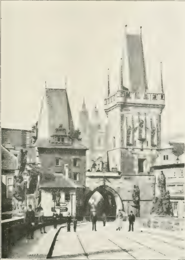
L'une des tours du vieux pont.
